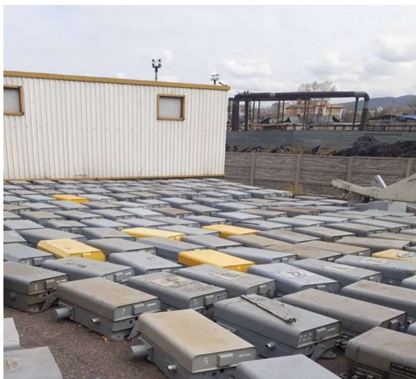
Рис. 1. Стрелочные электроприводы СП-6МГ, ожидающие разборки
