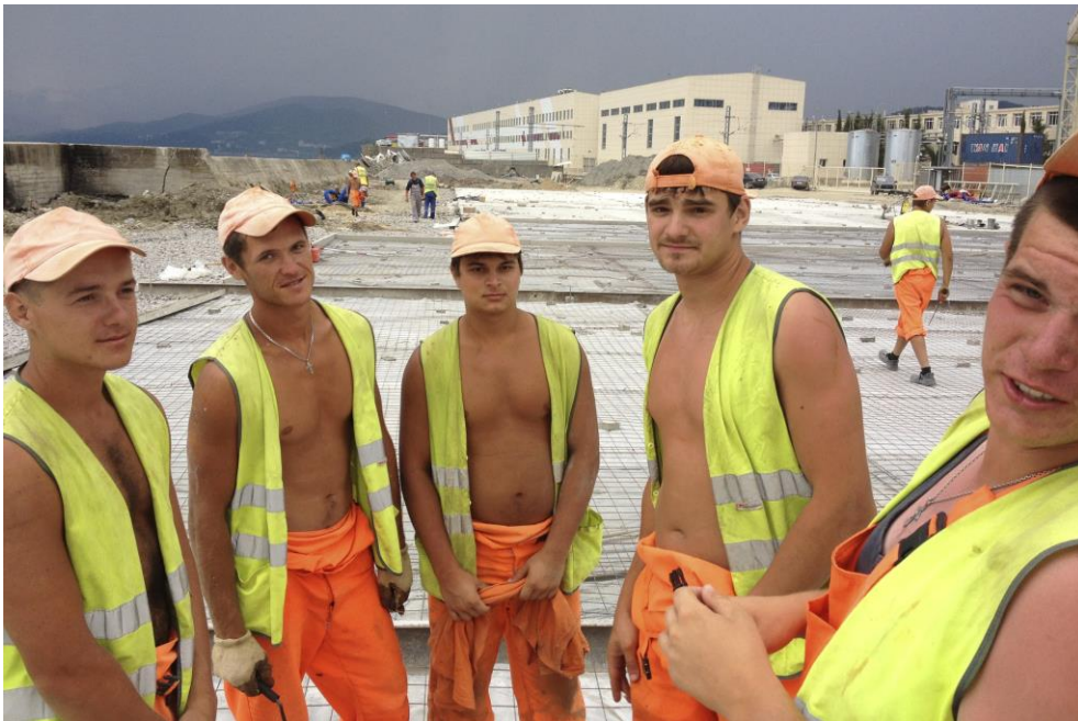
2013 год. ССО «Байкал». г. Адлер. Бетонирование привокзальной площади.
