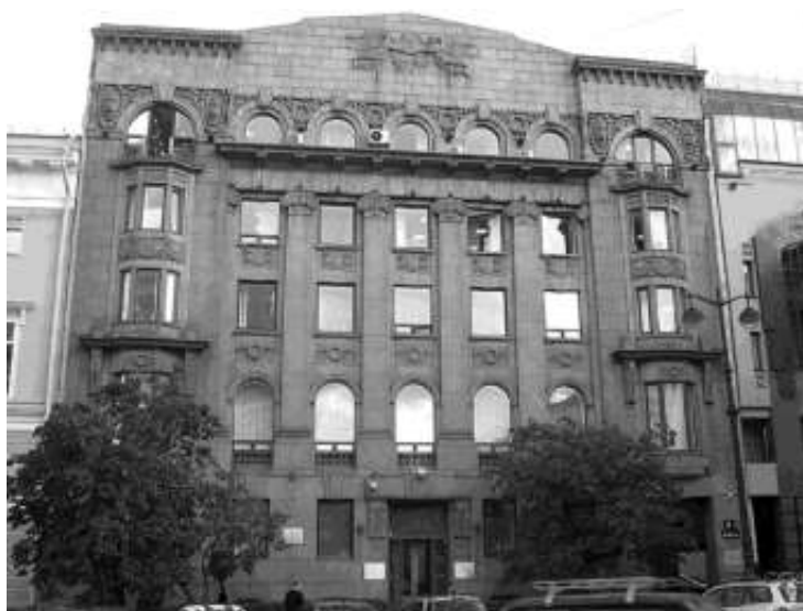
Рис. 5. Здание правления Северо-Западных железных дорог
