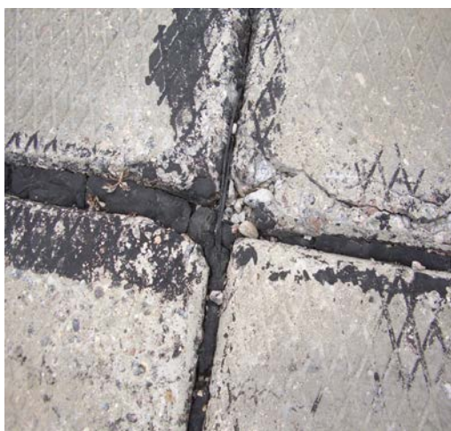
Рис. 1. Разрушение бетонного покрытия ВПП и РД
