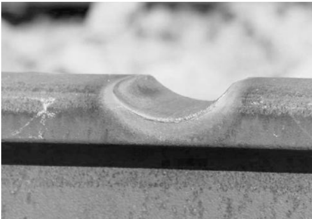
Рис. 3. Процесс зачистки углошлифовальной машинкой от шлака и остатков стали
