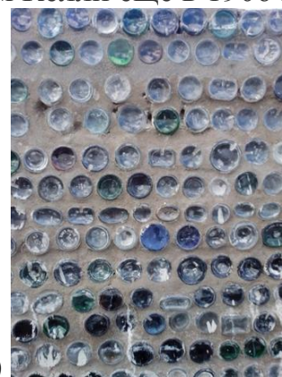
Рис. 2. Эко-юрта в пос. Харанцы на острове Ольхон по состоянию на 1 декабря 2017г. (Авторы проекта Пётр Холутов (местный фермер) и Сергей Полищук (доцент кафедры СЖДМиТ, ИрГУПС)): а) общий вид; б) стена юрты вблизи
