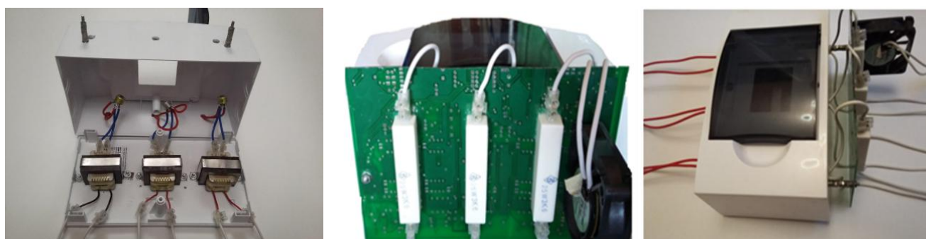
Рис. 3. Разработка измерительного блока и его монтаж
