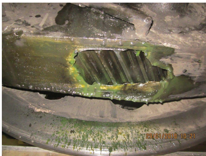
Рис. 2 – Повреждение кожуха после столкновения с препятствием
