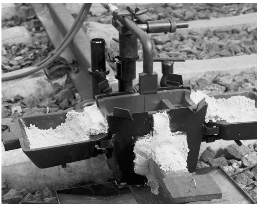
Рис. 4. Установка горелки предварительного подогрева вместе с формами
