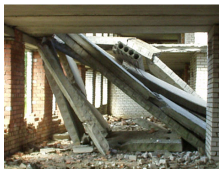
Рис.1. Дефекты и разрушения железобетонных плит
