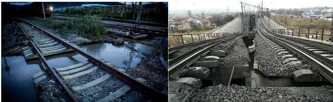
Рис. 2. Характер воздействия атмосферных осадков, грунтовых вод и термокарстовых котловин на железнодорожные пути в районах Западно-Сибирской равнины
