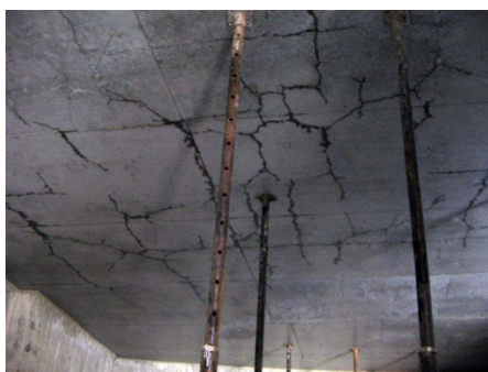
Рис.1. Дефекты и разрушения железобетонных плит
