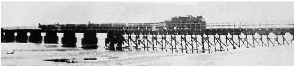
Рис. 8. Поезд с углем на мосту через р. Тола
