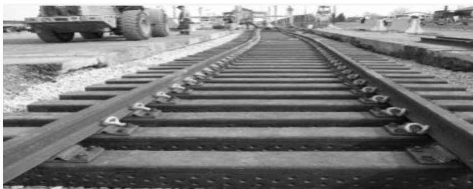
Рисунок 2. Путь, уложенный на композитных шпалах
