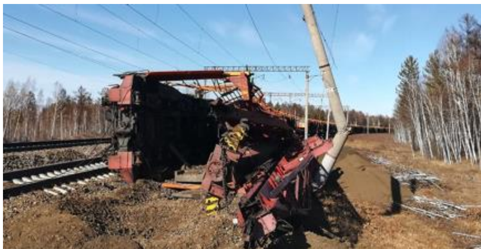
Рисунок 4 – Опрокинутый укладочный кран
