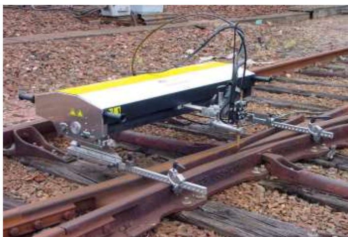
Рисунок 2 – Трансламатик вариант установки для наплавки крестовин
