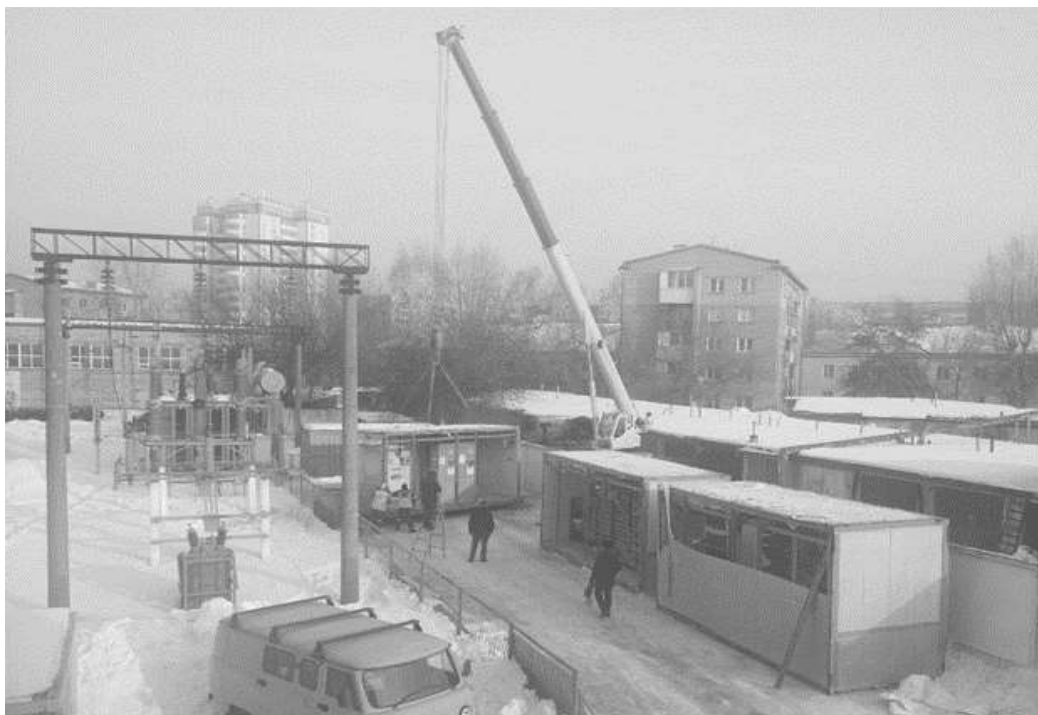
Рисунок 3 – Разгрузочные операции модулей МП, МР на полигоне
