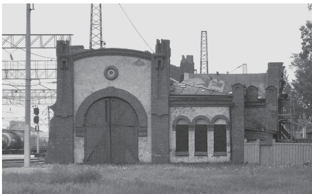
Станция Иркутск-Сортировочный. Бывшее оборотное паровозное депо (весовая мастерская). 2007 г.
