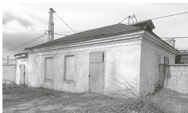
Буфет «Красная шапочка». Вид со стороны ул. Вокзальной
