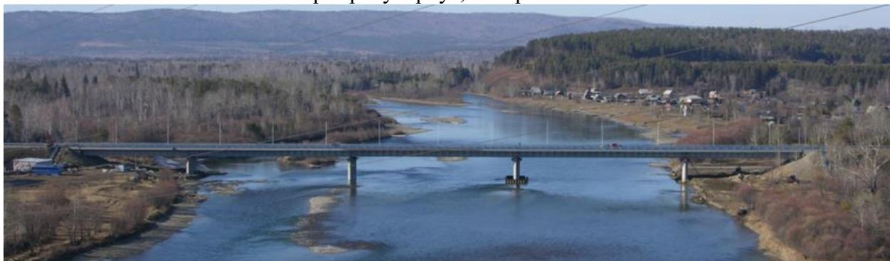
Разрезная балочная, **неразрезная балочная**, консольно-балочная, рамная
