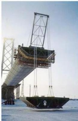
**Навесной монтаж**, продольная надвигка, установка кранами, наплавной способ
