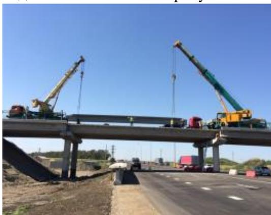
Навесной монтаж, продольная надвигка, **установка кранами**, наплавной способ
